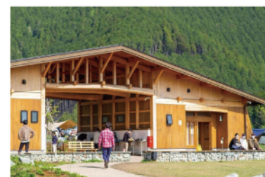
キャンプ場中央に新設したトイレ。ふもとっぱらで伐採した木を使用し、釘などを使わない昔ながらの在来工法で作られている
