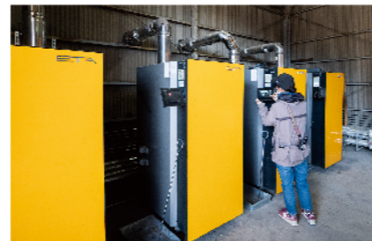
お湯を沸かす熱源は場内にある薪ボイラー。間伐材や端材を使ってお湯を沸かします
