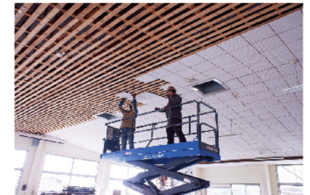
改装のために天井板を外す工事の様子
